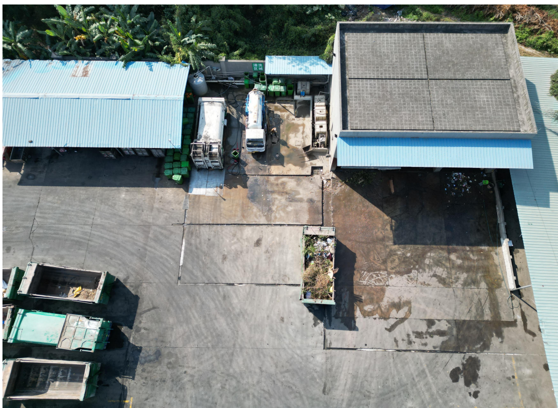
现状混凝土建筑及铁棚
